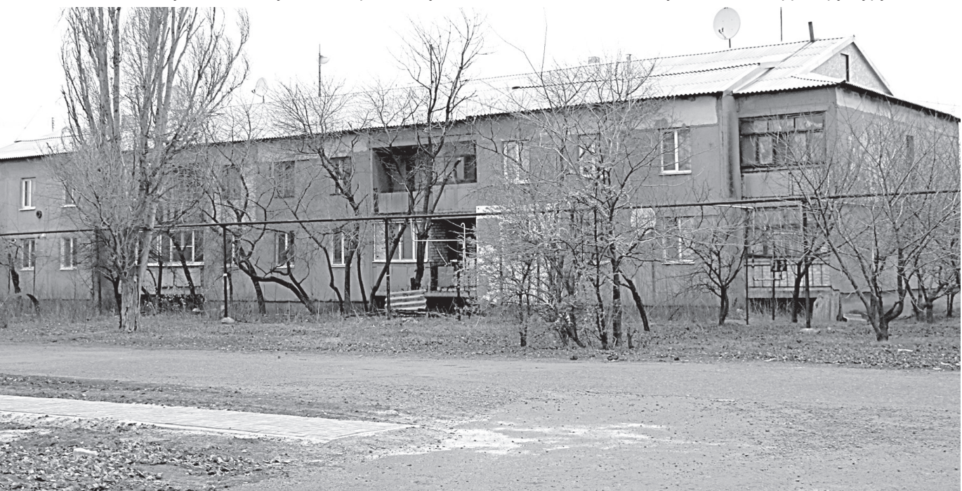
Отремонтировали кровли многоквартирных домов
