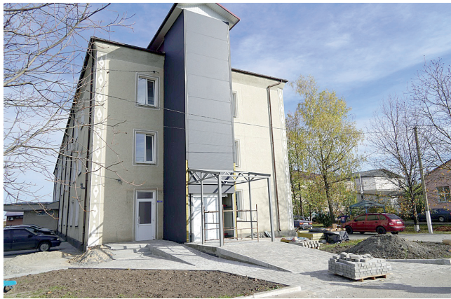
Будівництво ліфта біля хірургічного корпусу лікарні
